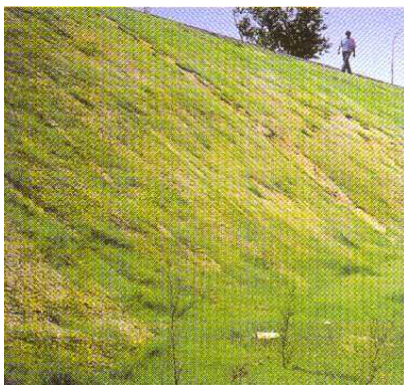
1. Trinter installeren op het talud
